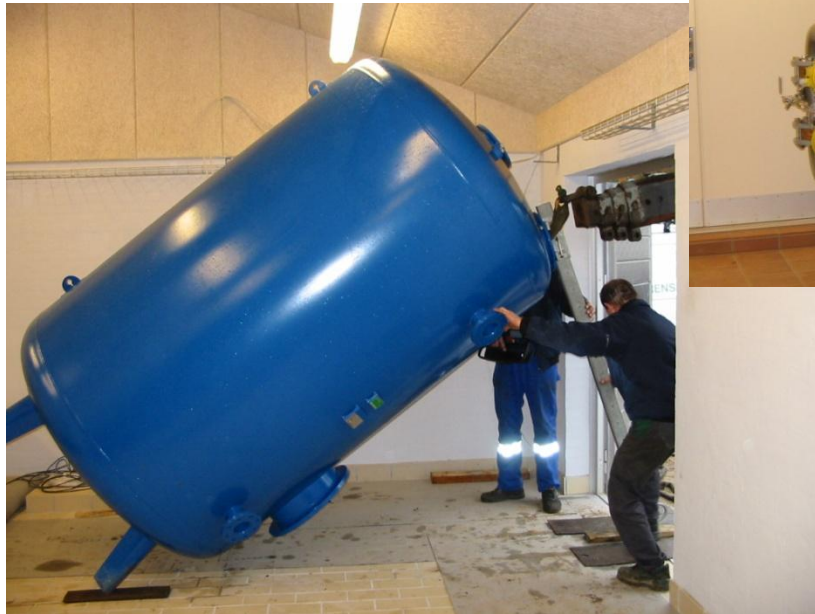
Fremstilling af rør og montage af trykfiltre
